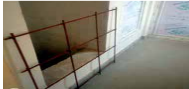
Terrace shaft edge protection
